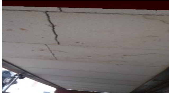
شكل رقم (12) الفشل في الترمستون في الوضع الأفقي
