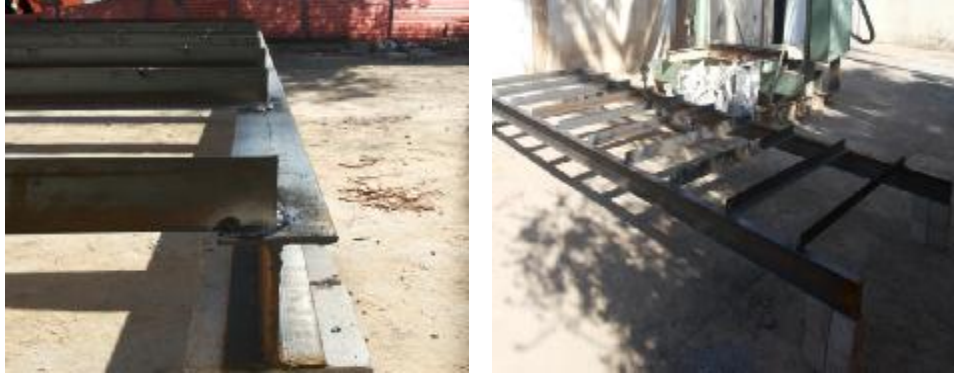
شكل رقم (6) الهيكل الحديدي بعد الربط والنتيبت
